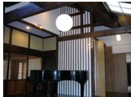
天井を撤去して、開放感のある、リビングに・・・。
